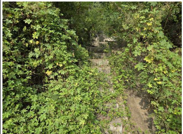
산마루측구, 점검계단 전경
