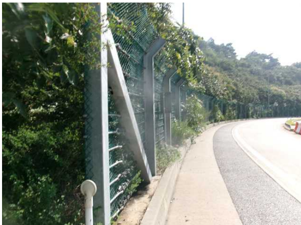
도로, 낙석방지울타리 전경
