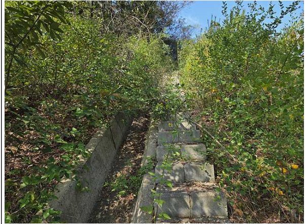
산마루측구, 점검계단 전경
