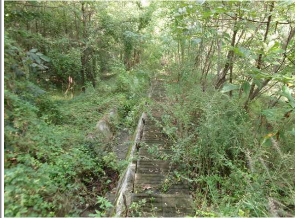
산마루측구, 점검계단 전경
