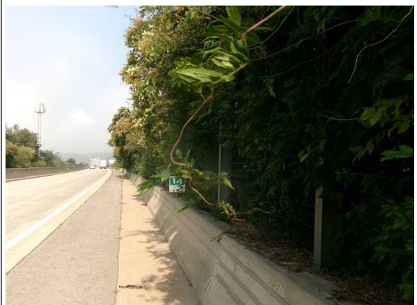
하부, 도로 전경
