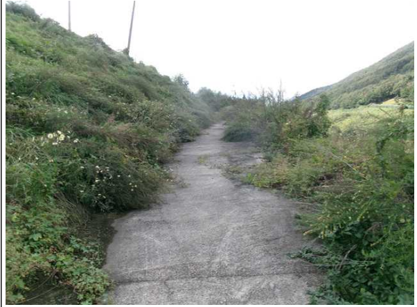
1소단 배수로 전경
