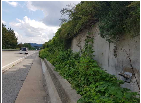
사면부, 하단 판넬형옹벽 전경
