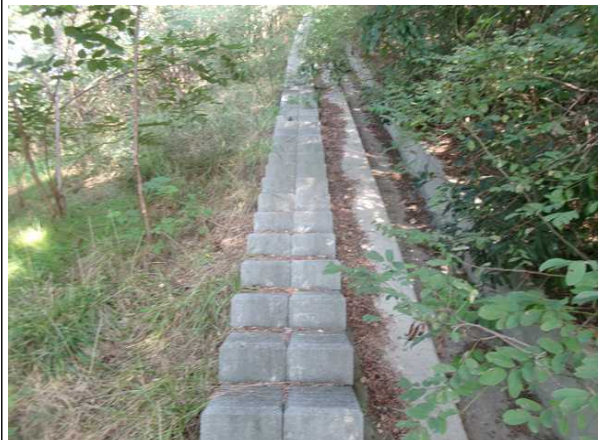
산마루측구, 점검계단 전경
