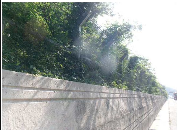
도로, 낙석방지울타리 전경
