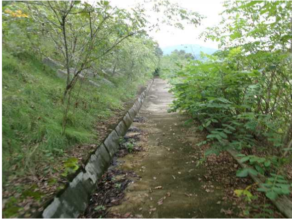
1소단 배수로 전경
