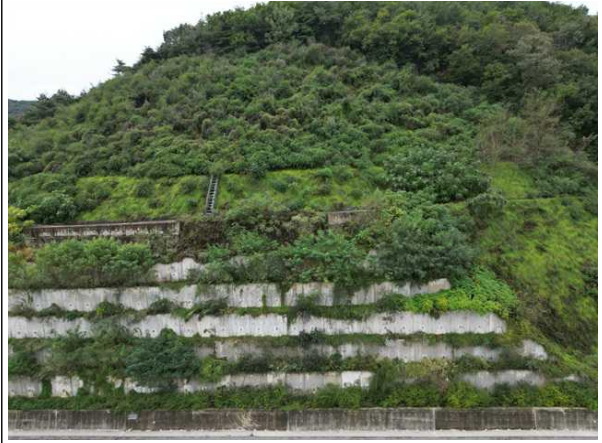
사면내 옹벽 전경
