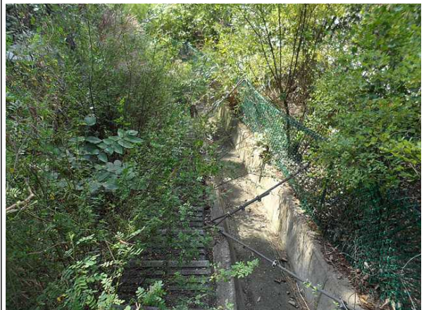
점검계단, 산마루측구 전경
