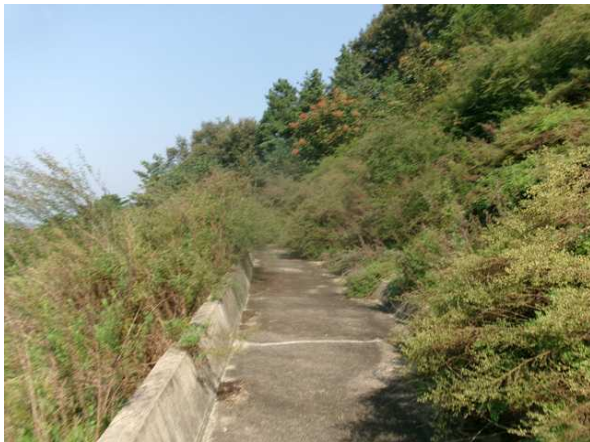
1소단 배수로 전경
