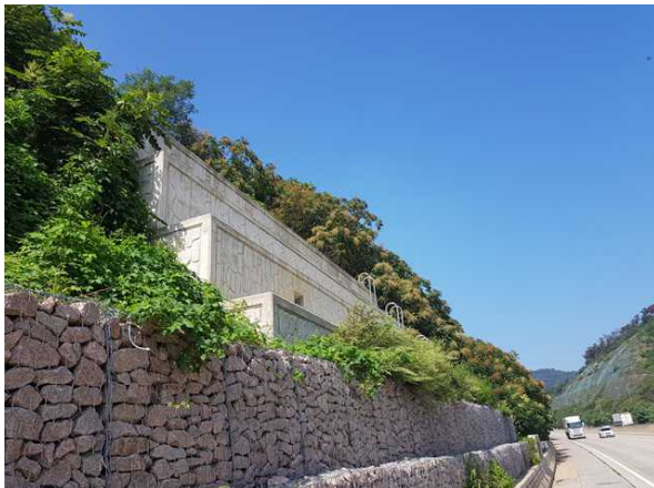
옹벽, 개비온 전경
