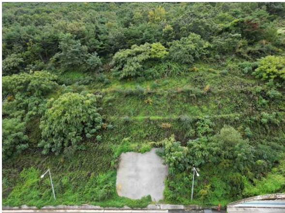
숏크리트 보호공 전경
