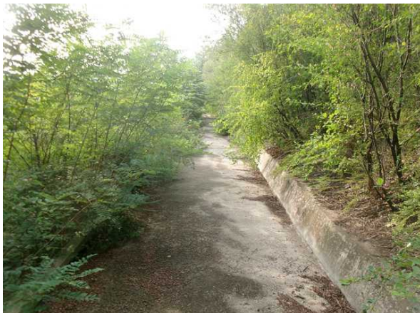
1소단 배수로 전경
