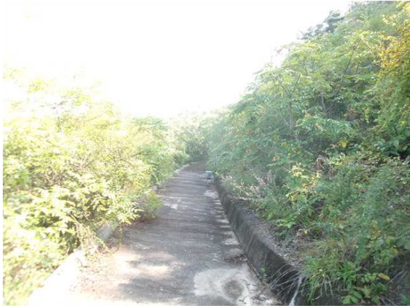
1소단 배수로 전경
