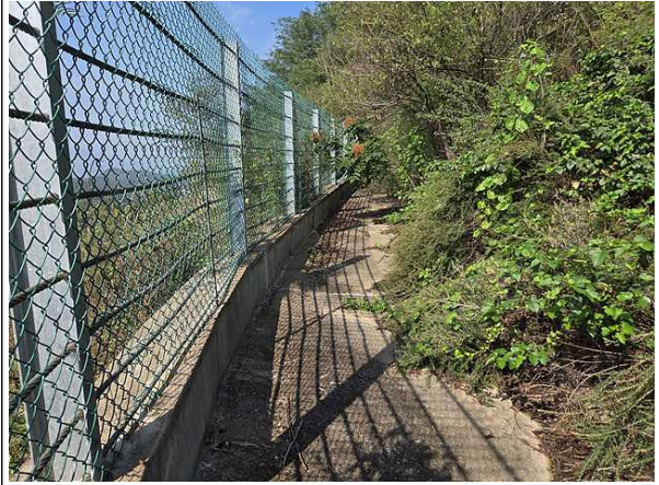
2소단 배수로 전경
