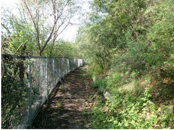
1소단 배수로 전경
