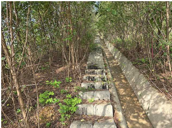
산마루측구, 점검계단 전경
