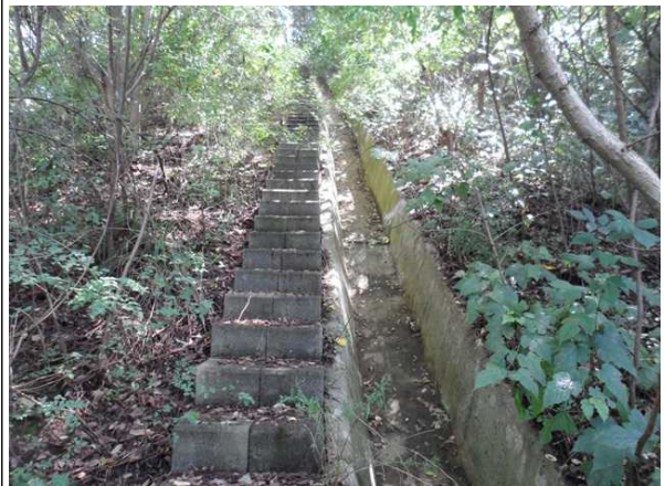
산마루측구, 점검계단 전경
