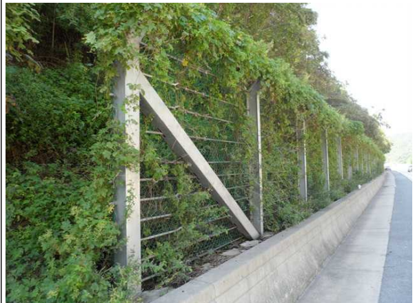
도로, 낙석방지울타리 전경
