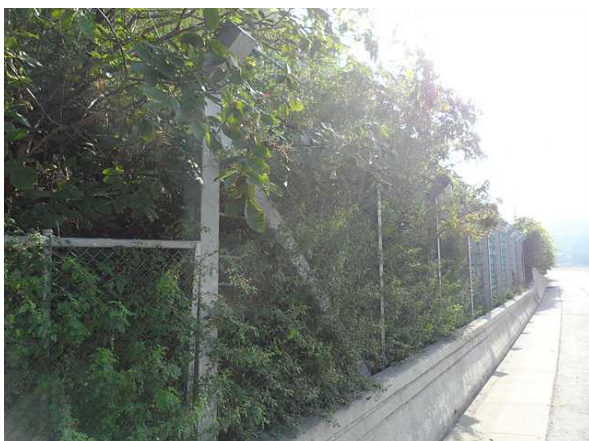
도로, 낙석방지울타리 전경
