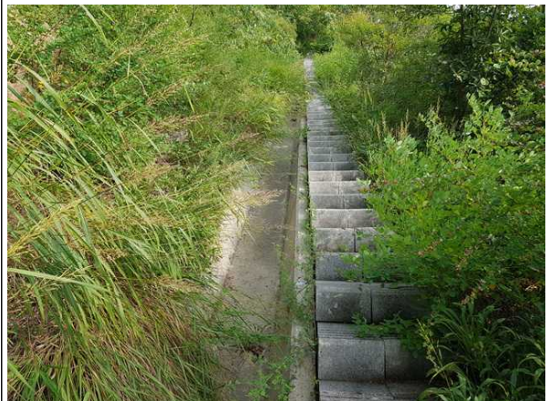
산마루측구, 점검계단 전경
