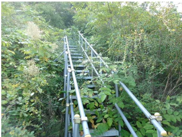
2단 점검계단 전경
