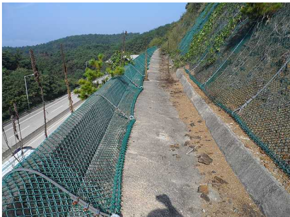
2소단 배수로 전경
