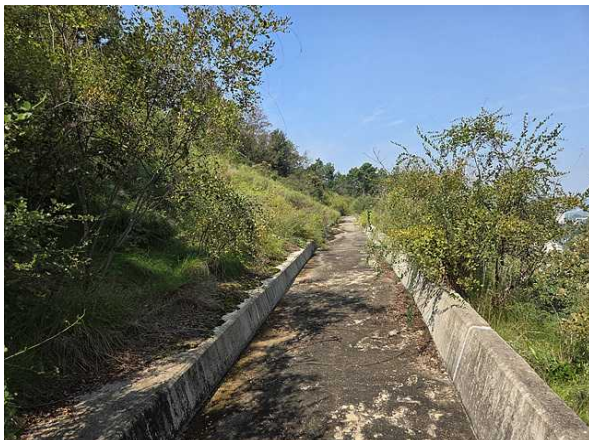
1소단 배수로 전경
