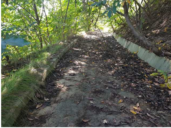
1소단 배수로 전경
