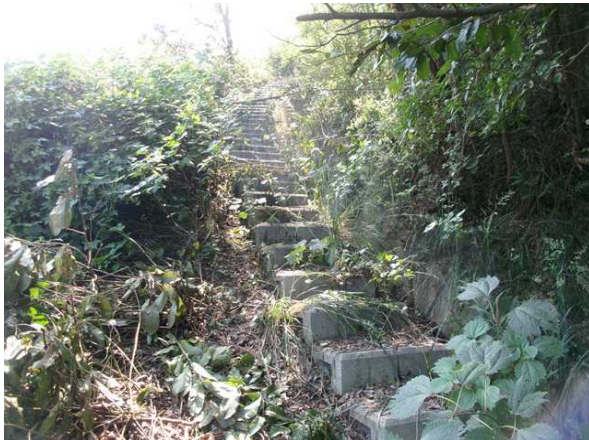
점점계단, 산마루측구 전경
