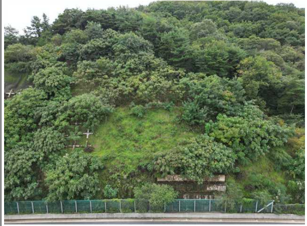
사면내 옹벽 전경
