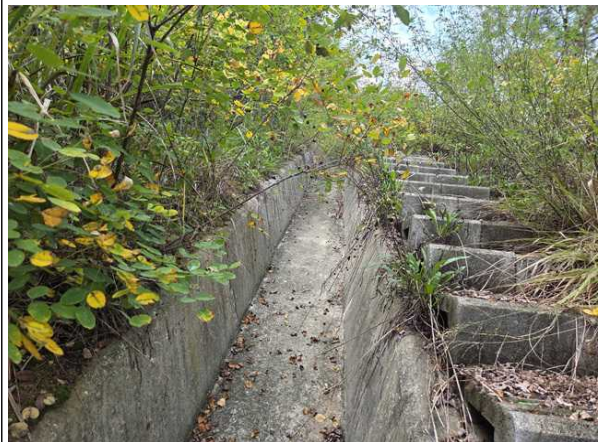
산마루측구, 점검계단 전경
