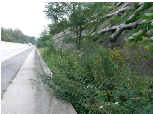
하부, 도로부 전경
