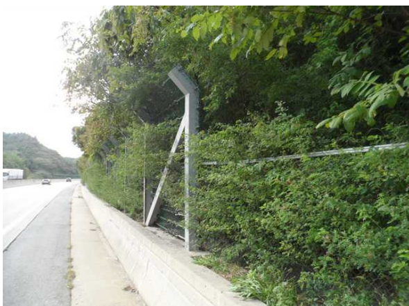
하부, 낙석방지울타리 전경
