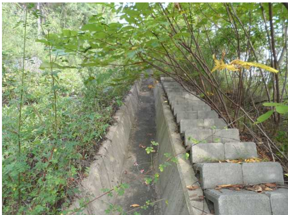
산마루측구, 점검계단 전경
