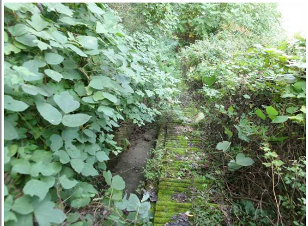
산마루측구, 점검계단 전경
