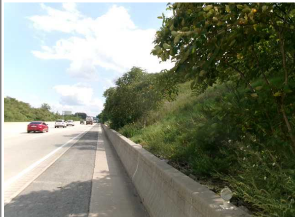
도로, 하부 전경
