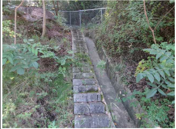
산마루측구, 점검계단 전경
