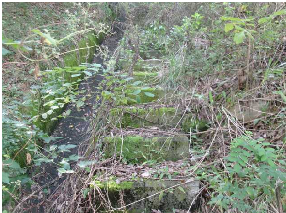
산마루측구, 점검계단 전경
