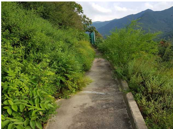
소단배수로, 낙석방지울타리 전경
