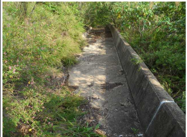
1소단 배수로 전경
