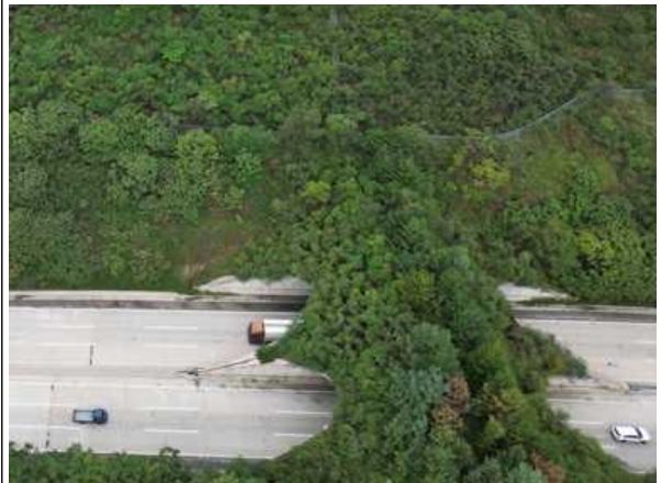
상태육교 상부 전경
