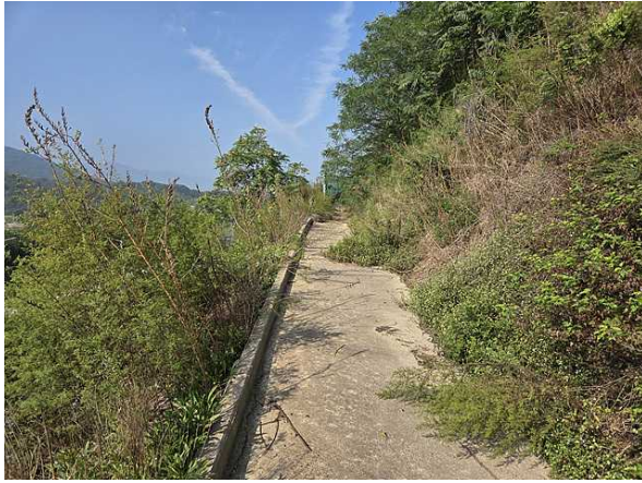
1소단 배수로 전경
