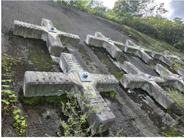
-shot리트, 격자앵커 전경
