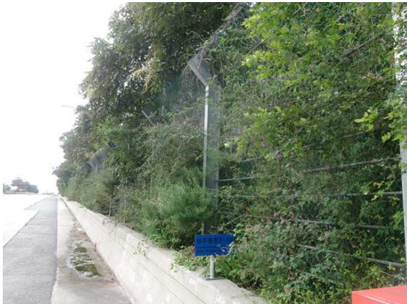
도로, 낙석방지울타리 전경
