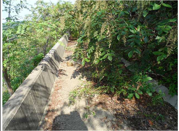
1소단 배수로 전경
